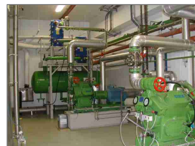
Figur 7 Eksempel på Japanske CO 2 -varmepumper for varmtvannsberedning basert på teknologi utviklet ved SINTEF Energi AS og NTNU, Institutt for energi- og prosesseteknikk.
